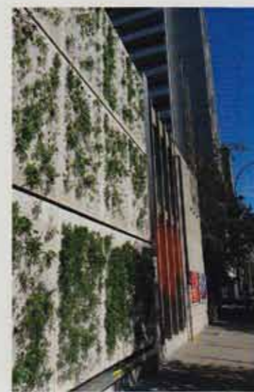
Le système pour façade végétale Skyflor® développé par Hepia et Creabéton Matériaux, installé à la rue Pictet à Genève.
