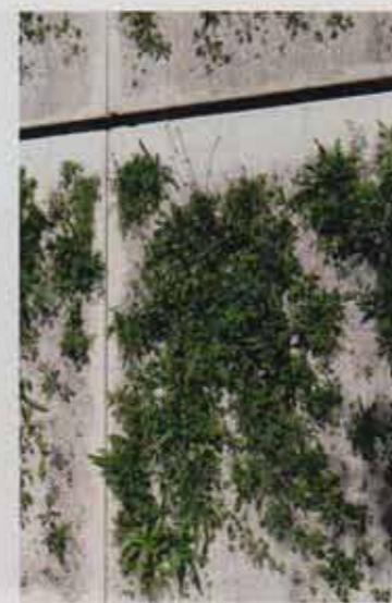
Le système pour façade végétale Skyflor® développé par Hepia et Creabéton Matériaux, installé à la rue Pictet à Genève.
