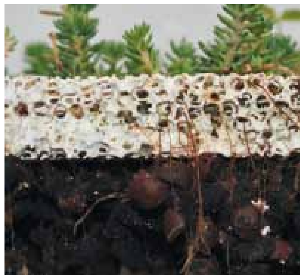
Querschnitt (oben) durch Skyflor® und Detail (unten)
